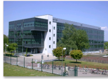
Das CeBiTec Gebäude der Universität Bielefeld
